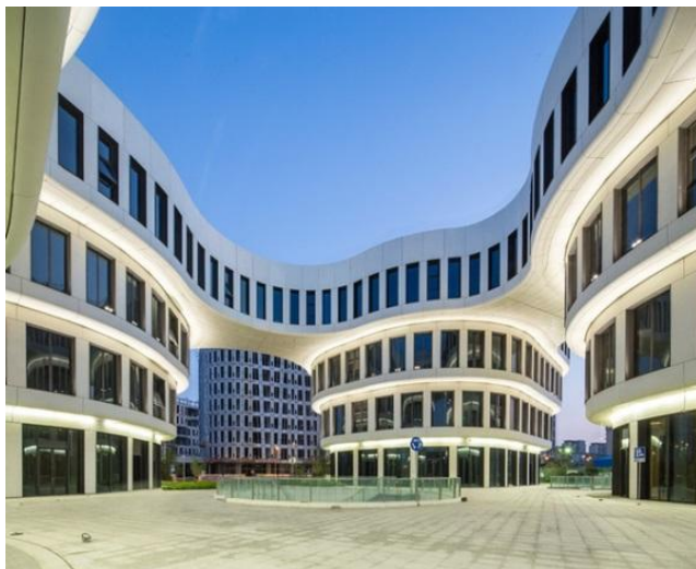
Рисунок 3 – Внутренняя часть здания
