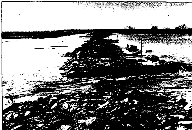
Размыв продольной дамбы затопливаемого польдера «Загорье» Чечерского района
