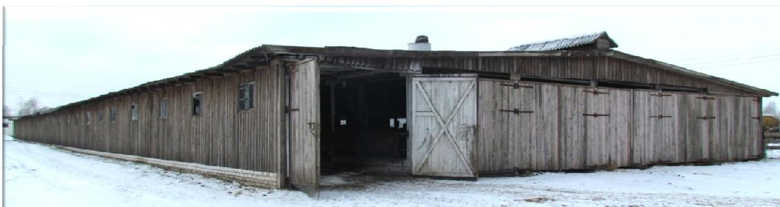
Помещение из облегчённых и дешёвых конструкций (необрезная доска, деревянные подвесные столбы, стропила и лаги крыши, шифер, бывшие в употреблении металлические малые рельсы, трубы, уголок, проволока, бетонные опоры) для содержания маточного поголовья после отъёма телят на глубокой подстилке (ОАО «Туровщина» Житковичского района)
