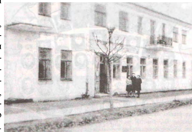
Учебный корпус техникума на улице Островского, 22 (в настоящее время улица Иркутско-Пинской дивизии, 22). 1948 год
